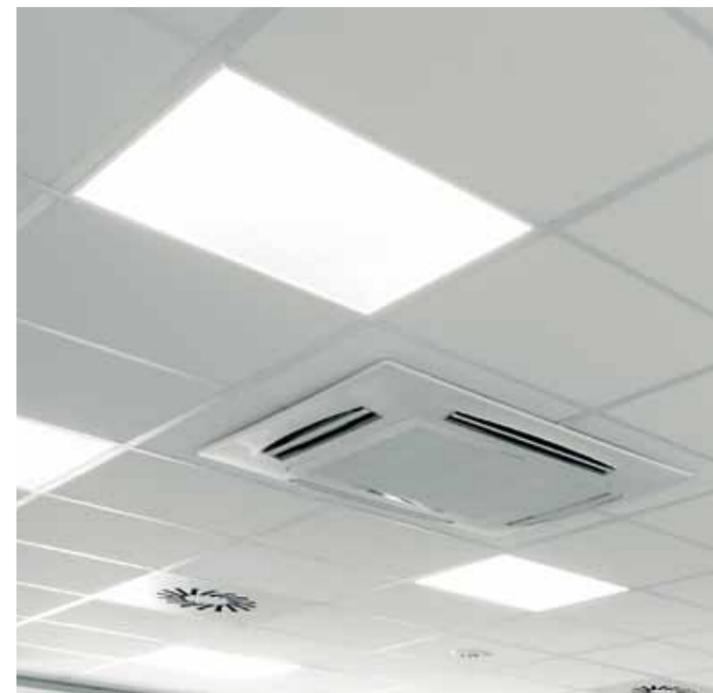
Als Regel gilt, dass auf 2,5 W elektrischer Energie einer Leuchte 1W elektrischer Energie der Klimaanlage entfällt, und steigt der Energieverbrauch des Beleuchtungssystems, steigt auch unmittelbar der Energieverbrauch für den Betrieb der Klimaanlage.
